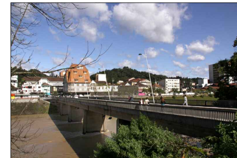
PONTE ADOLFO KONDER
